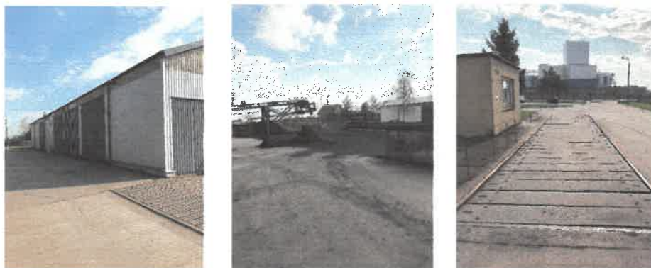
Fot Nr 8-10 budynek magazynowo garażowy, skład żużla, waga najazdowa
