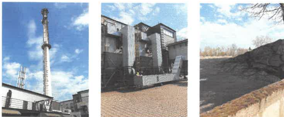
Fot Nr 1-3 przedstawiają: budynek kotłowni oraz miejsce magazynowe mialu węglowego
