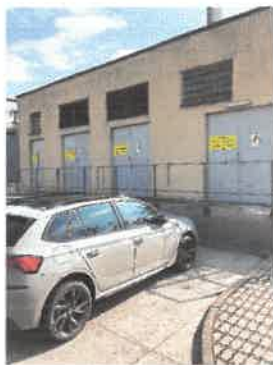
Fot. Nr 7 budynek rozdzielni elektrycznej widok od frontu
